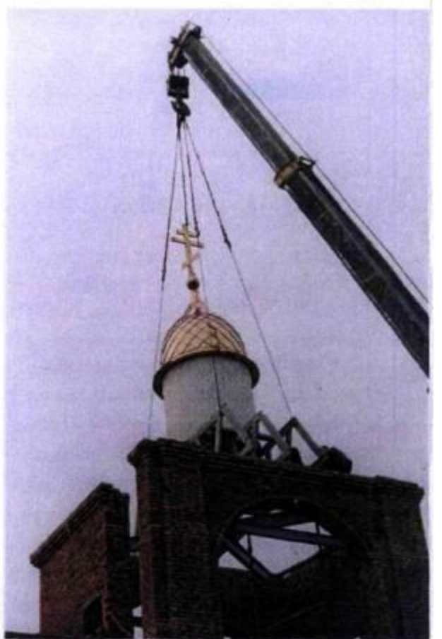
Монтаж венчающей части звонницы
